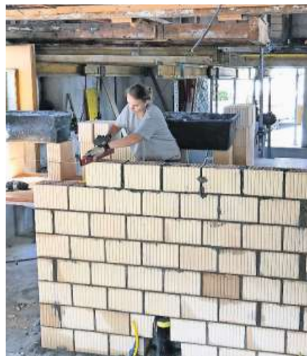
Zu Beginn erfolgte der Abbruch von Verkleidung, Wänden und Böden bis auf die Balken (oben links). Als Nächstes brachten die Zimmermänner den Holzboden ein. Es folgte ein Wirrwarr von Leerrohren für Strom- und Netzkabel (oben Mitte). Nach dem Betonieren war nichts mehr davon zu sehen. Martina Raissles erste Mauerversuche mit Schnur und Wasserwaage (unten links). Befestigung der Decken-Spotlights auf der Schalung mit Tochter Elisa (links). Bilder: Martina Raissle/Jasmin Reichlin
